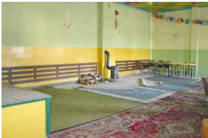
świetlica przed remontem
