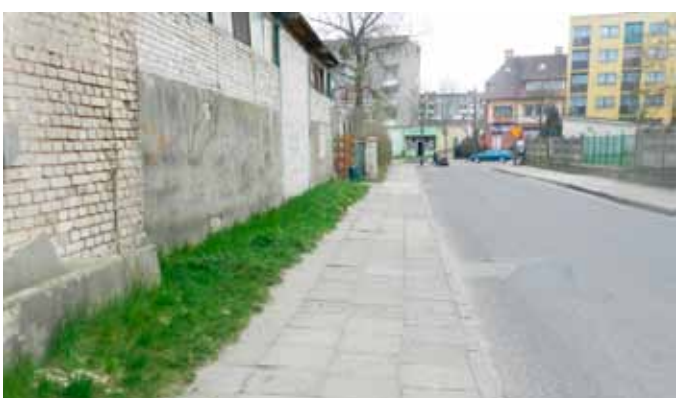
Ulica Młynarska – naprawa chodnika po prawej stronie (idąc od ul 15 Lutego) metodą wymiany uszkodzonych obecnych płyt i uzupełnianie innymi z odzysku
