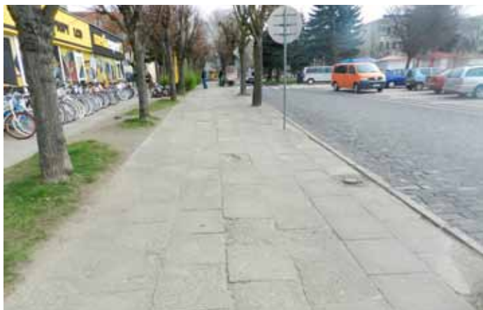
Chodnik wykonany będzie na całej długości z kostki polbruk
