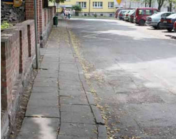
ul. Kościelna przed remontem
